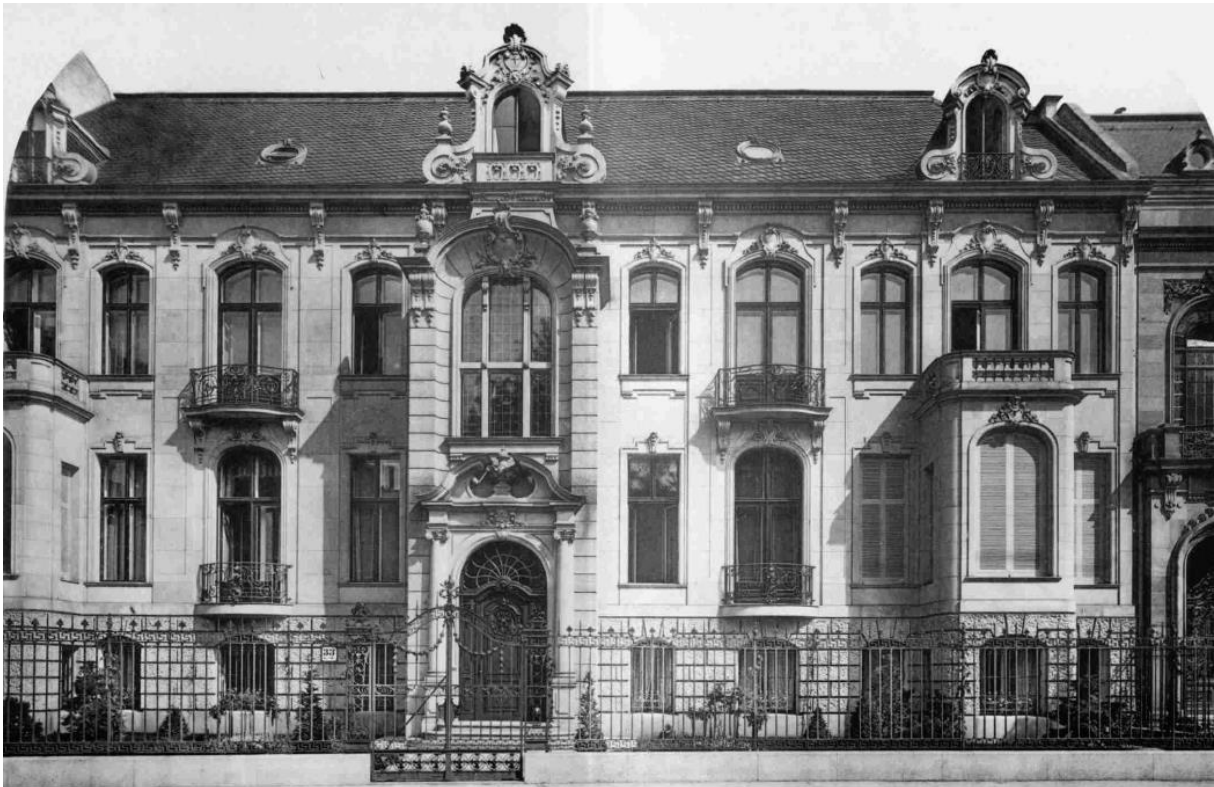
Wohnhaus in Berlin, Matthäikirchstr. 33, erbaut 1893-94.
